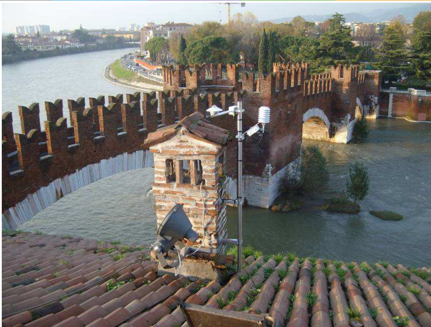
Irraggiamento solare, temperatura e umidità relativa sul tetto
